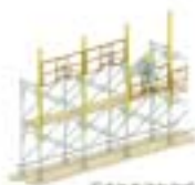
手すり完成式方式の例
