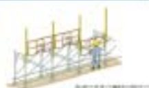
図1-1の手すり先送り組立て
